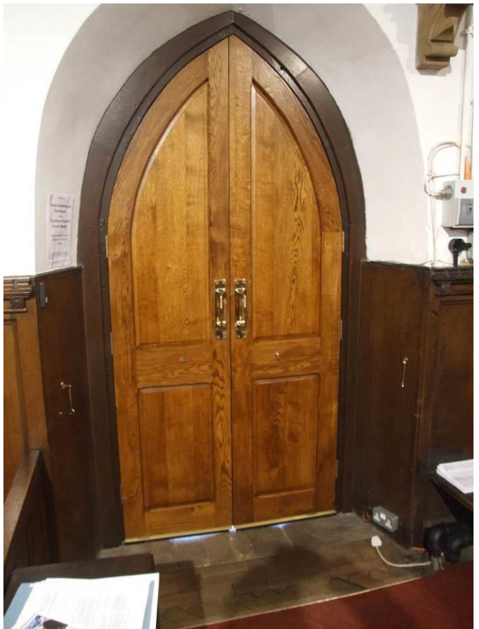
Fig. 23 (IMG 1347) New porch doors
