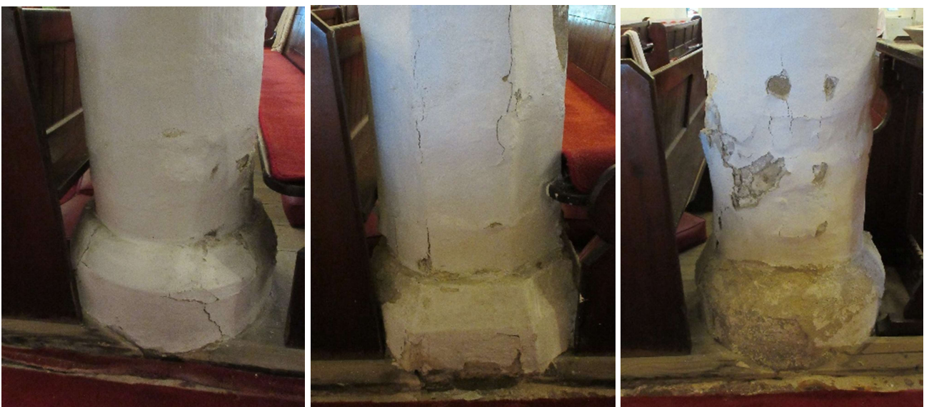
NE pier aisle side 2017
