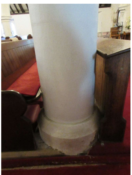
SE pier aisle side 2017
