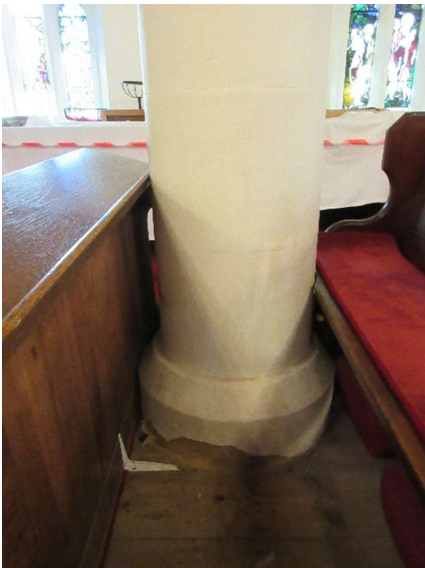
SE pier nave side 2017
