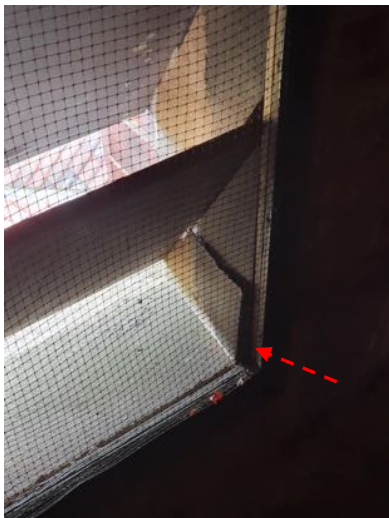
a) Eroded jamb
