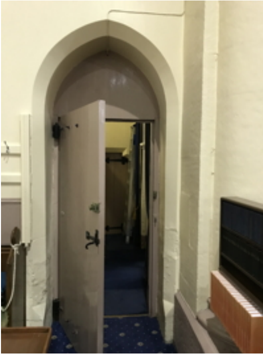
South Aisle/Porch Door
