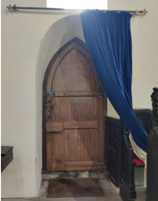
27. Chancel S door
